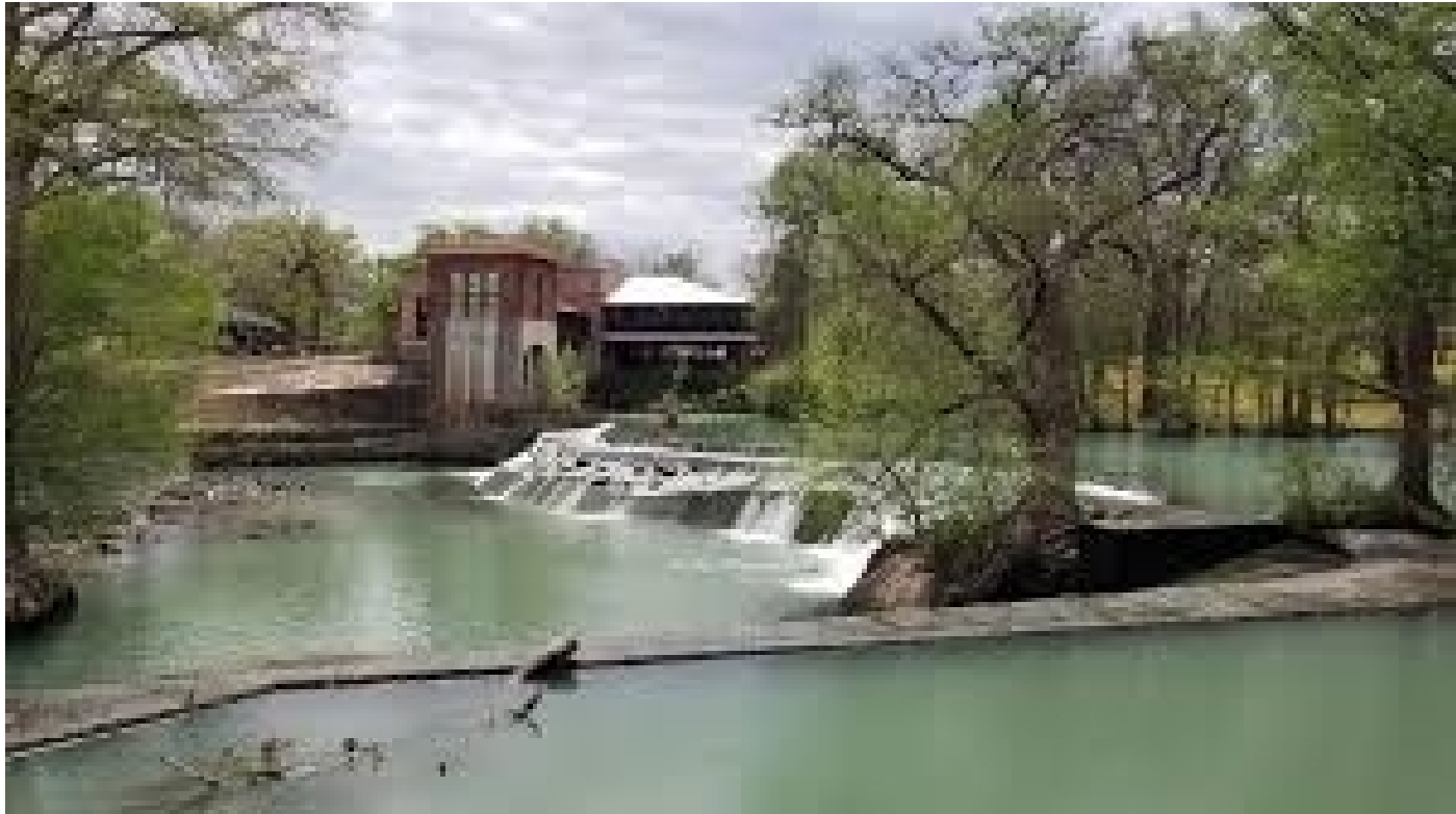
Safford Dam, Seguin
