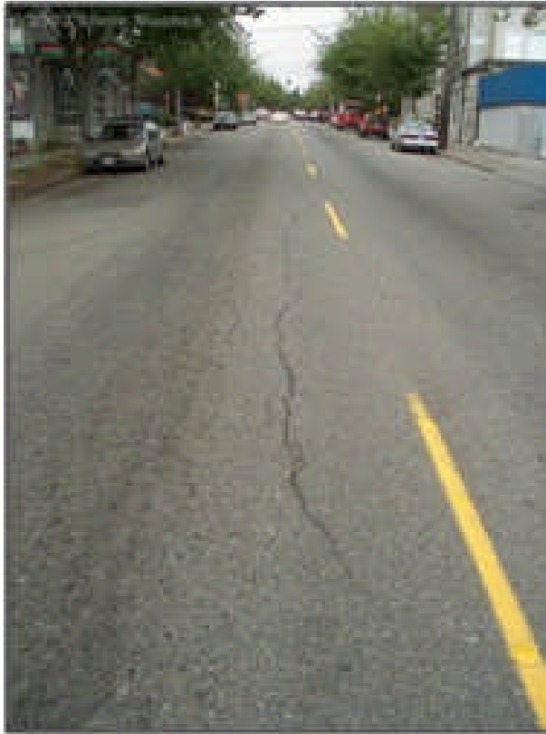
Longitudinal Cracking
